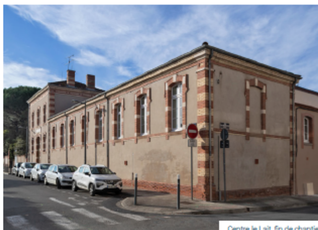
Centre le Lait, fin de chantier
